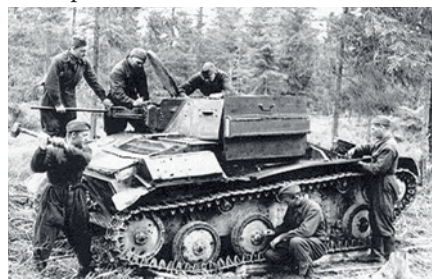
Ремонт в поле
